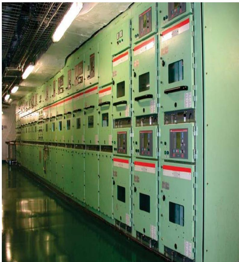
Altro elemento essenziale nella switchboard sono i pannelli per la sincronizzazione dei vari generatori o tra sbarre. Grazie a questi è possibile operare la messa in parallelo in manuale di tutti quei sistemi già alimentati, per esempio i Generatori, i congiuntori e gli interconnettori.
