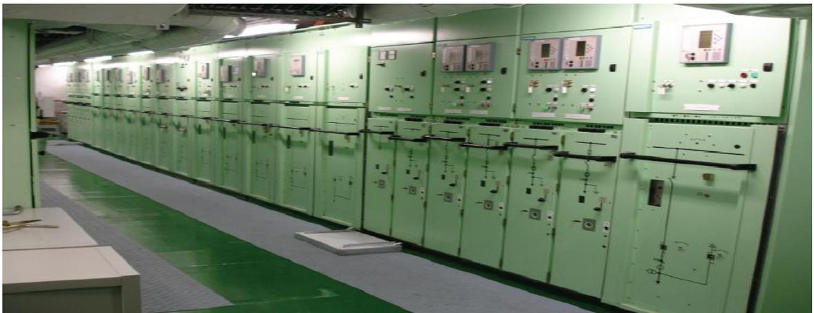
La funzione della switchboard è quella di controllare e distribuire l'energia elettrica agli utenti/generatori ad essa collegati. Assolve principalmente a due funzionalità e cioè esegue operazioni di controllo di tipo operativo per la normale conduzione degli impianti, apertura e chiusura di breakers, e deve effettuare operazioni di apertura e messa a terra delle linee di alimentazione in modo tale da permettere la manutenzione in tutta sicurezza.
