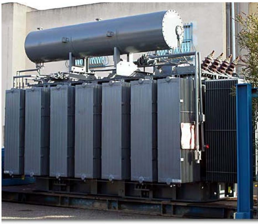
Fig. 1.2: Trasformatore da 25 MVA per sottostazione di distribuzione
